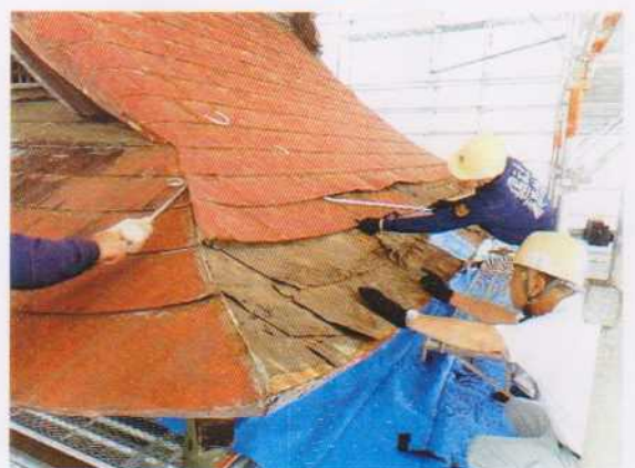
屋根鉄板解体 2017.8.21
