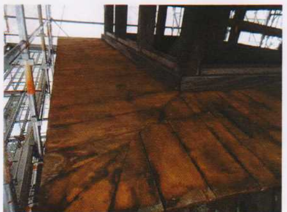
縁板覆い鉄板解体完了 2017.8.23
