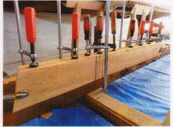
裏甲剥木繕い 2017.11.29
