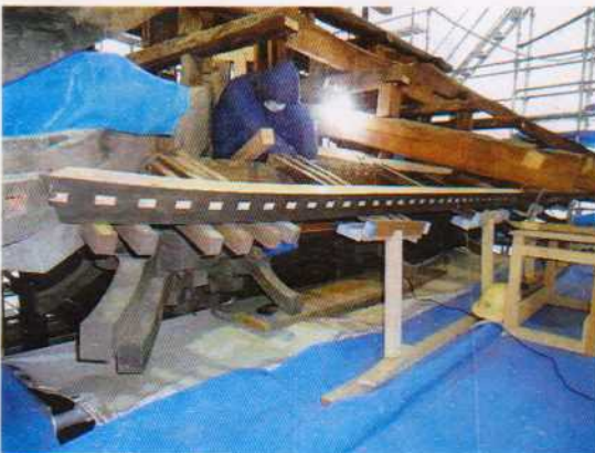
木負（取替材）取付 2017.1.19
