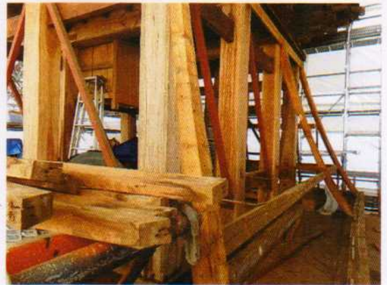
袴腰下地解体 2017.10.14
