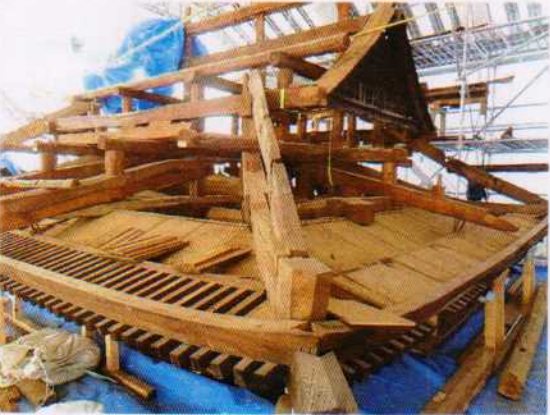
化粧裏板解体 2017.10.14
