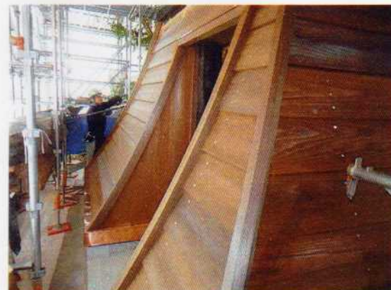
袴腰下見板張り 2018.7.27
