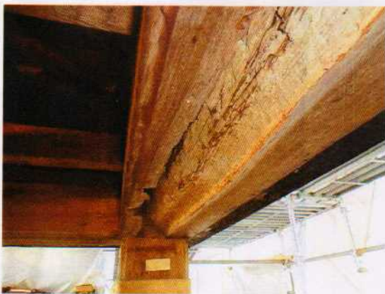
1階台輪下盤木腐れ除去 2017.11.3
