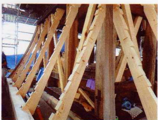
袴腰下見板下地組立 2018.7.12
