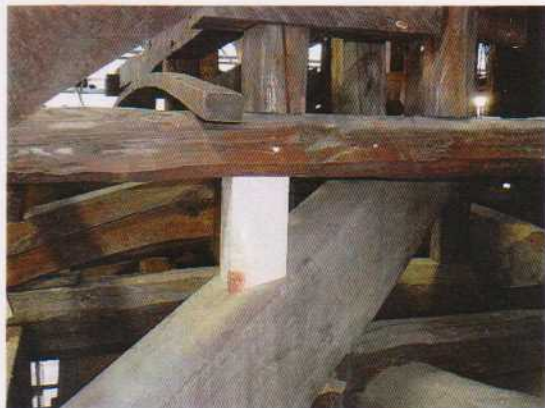
小屋束の補強 2018.3.8
