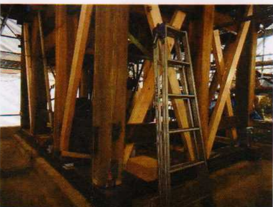
軸部筋違い（取替材）取付 2018.1.22
