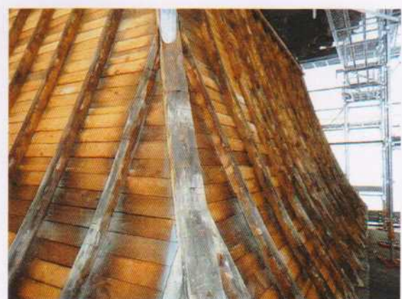
袴腰鉄板解体 2017.8.24
