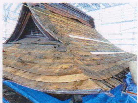
屋根鉄板解体完了 2017.8.22
