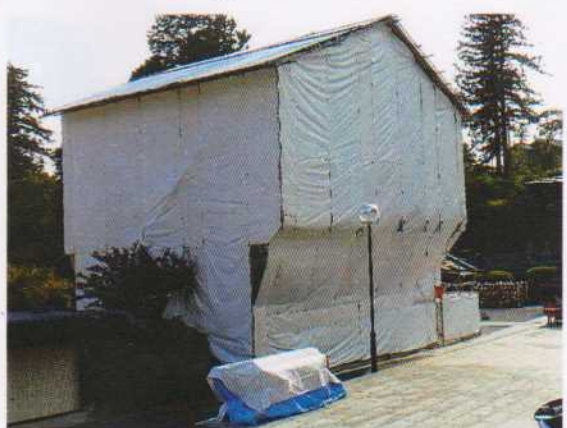
素屋根組立完了 2017.8.19
