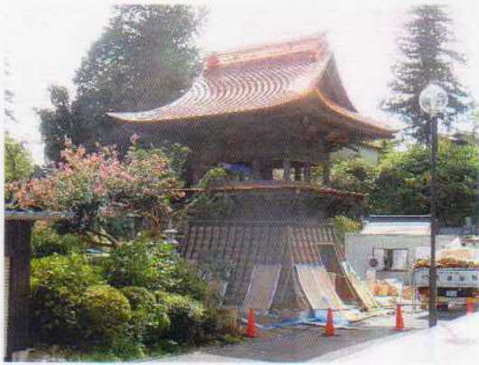
素屋根解体完了 2018.8.18
