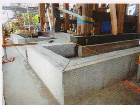
袴腰地覆基礎補修完了 2018.4.11
